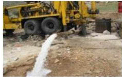
عملیات تست آب دهی چاه آهکی نمایی
