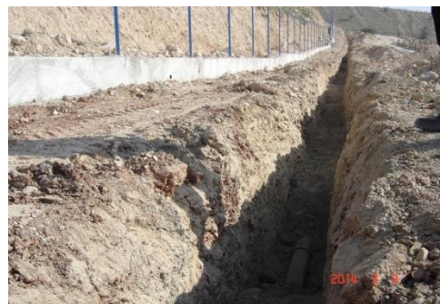
عملیات اجرایی بکفیل لوله های خط انتقال آب
