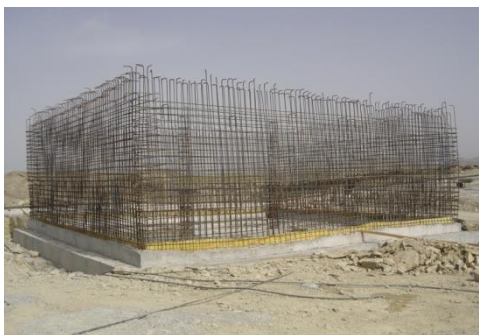
تکمیل آرماتوربندی دیواره مخزن بتنی
