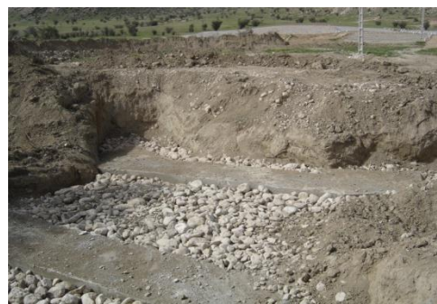
عملیات قله ریزی بین فونداسیون پل آبرو خط انتقال آب
