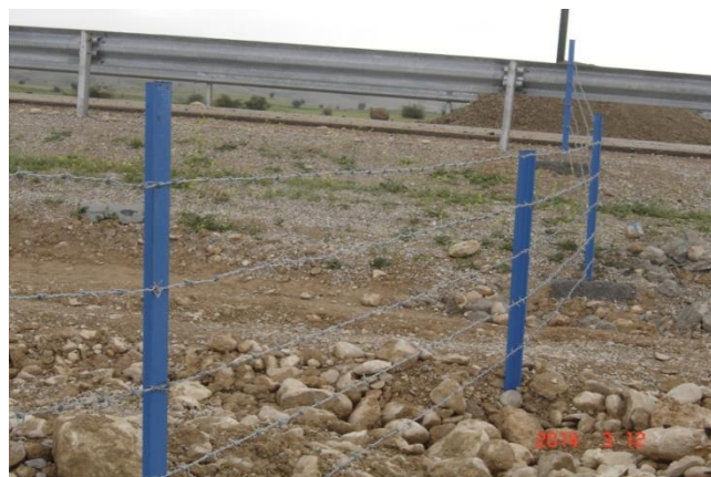
عملیات اجرایی نصب سیم خاردار پایه های کوتاه
