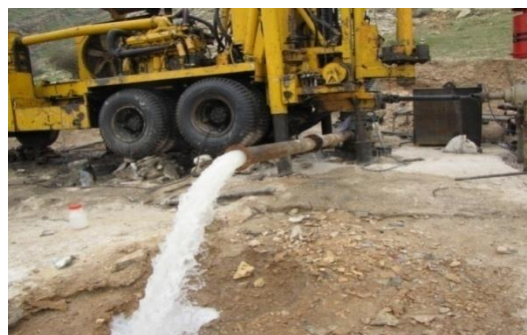
عملیات تست آب دهی چاه آهکی
