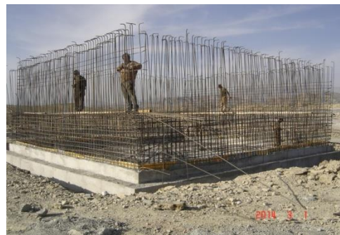
عملیات اجرایی آرماتوربندی دیواره مخزن بتنی
