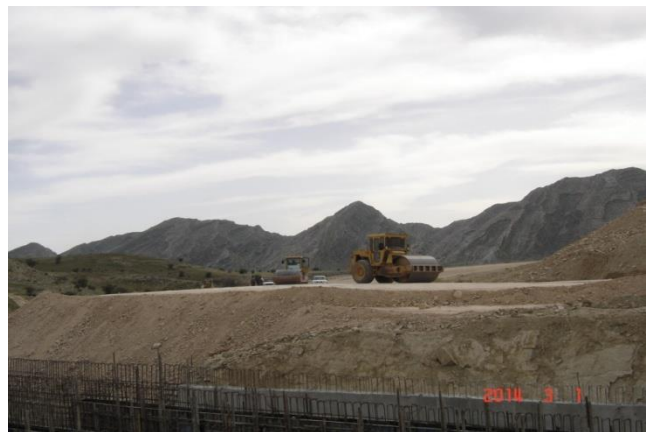
عملیات اجرایی خاکریزی و کوبش مسیر جاده ارتباطی
