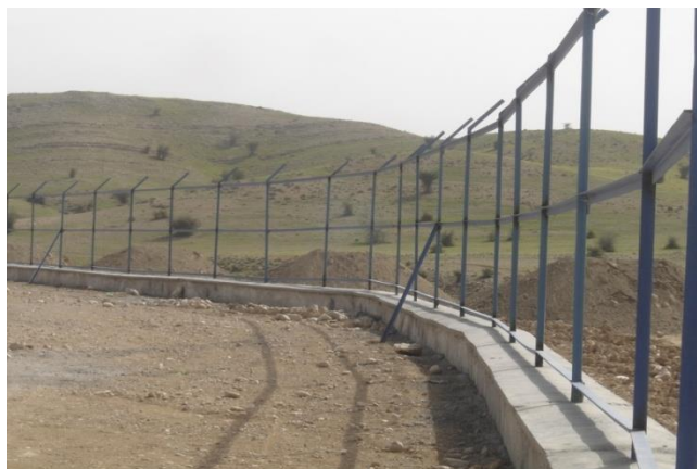
عملیات اجرایی نصب پایه و اتصالات عرضی فنس استاندارد
