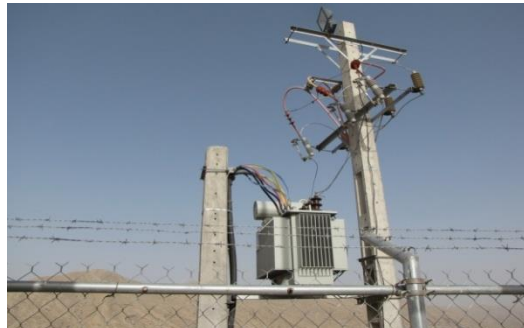
نصب ترانس وانتقال برق به طول ۶ کیلومتر
