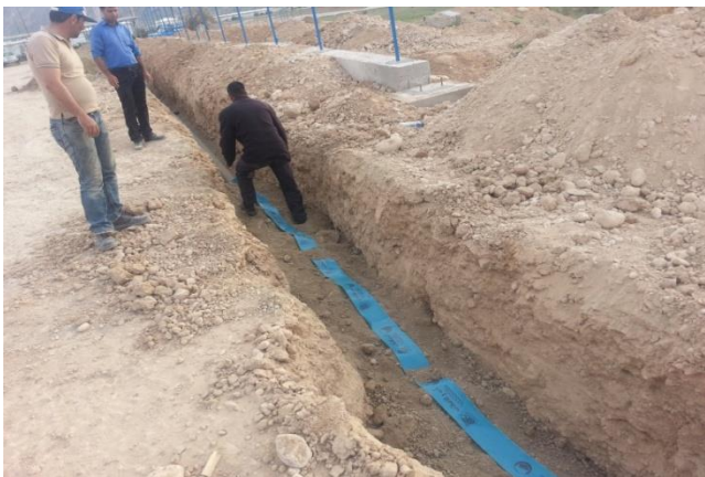
عملیات اجرایی لوله گذاری و نوار خطر خط انتقال آب
