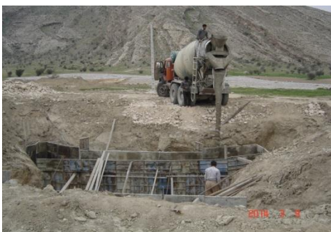
عملیات اجرایی بتن ریزی فونداسیون پل آبرو خط انتقال آب
