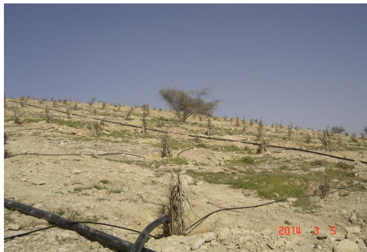
عملیات اجرایی لوله کشی جهت آبیاری قطره ای فضای سبز
