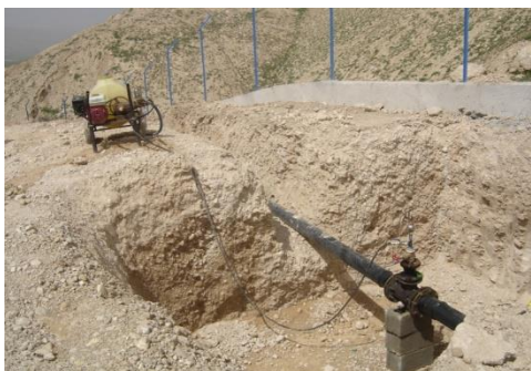
عملیات اجرایی تست لوله و اتصالات خط انتقال آب
