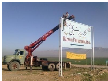
نصب تابلو ورودی پس از تحویل زمین
