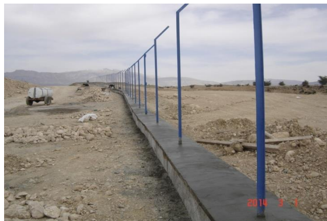
عملیات کارگذاری پایه ها و اجرای آبچکان فنس استاندارد
