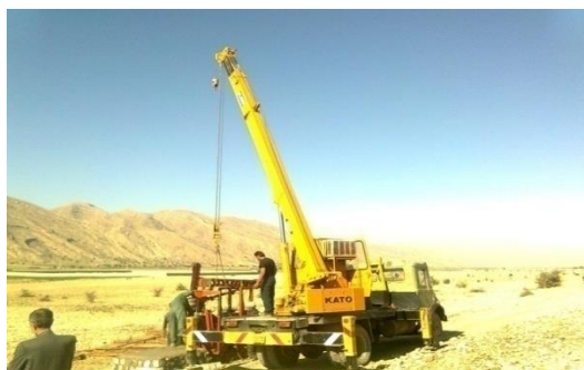
نمایی از ماشین آلات مخصوص عملیات ژئوتکنیک
