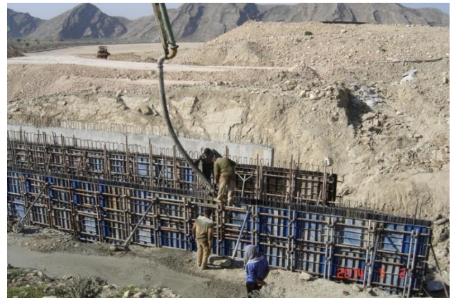
عملیات اجرایی قالب بندی و بتن ریزی دیواره پل ارتباطی
