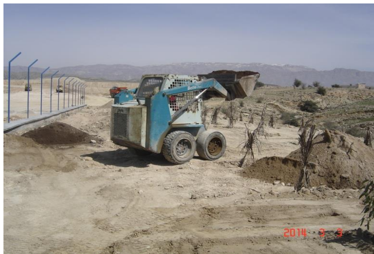
عملیات اجرایی کاشت نهال و تسطیح بین درختچه ها
