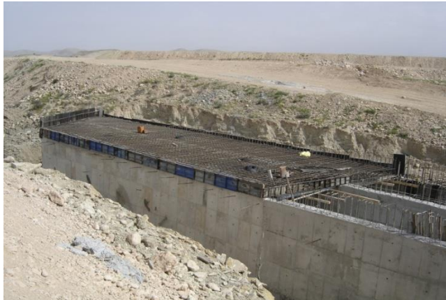
عملیات اجرایی قالب بندی و آرماتوربندی سقف پل ارتباطی
