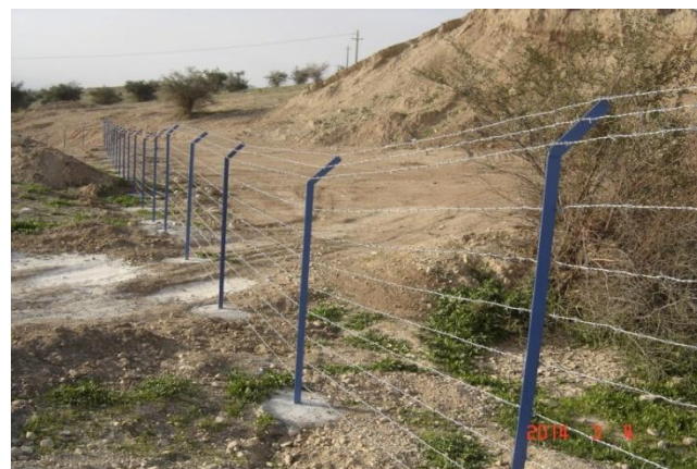
عملیات اجرایی نصب سیم خاردار پایه های بلند
