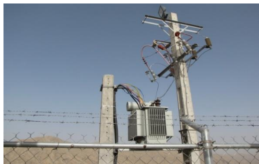
نصب ترانس وانتقال برق به طول ۶ کیلومتر
