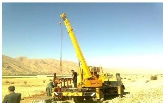
نمایی از ماشین آلات مخصوص عملیات ژئوتکنیک
