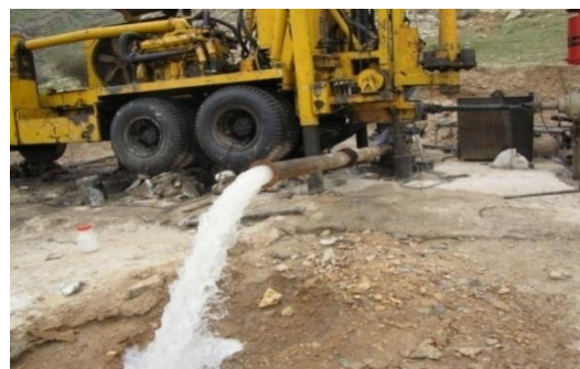
عملیات تست آب دهی چاه آهکی
