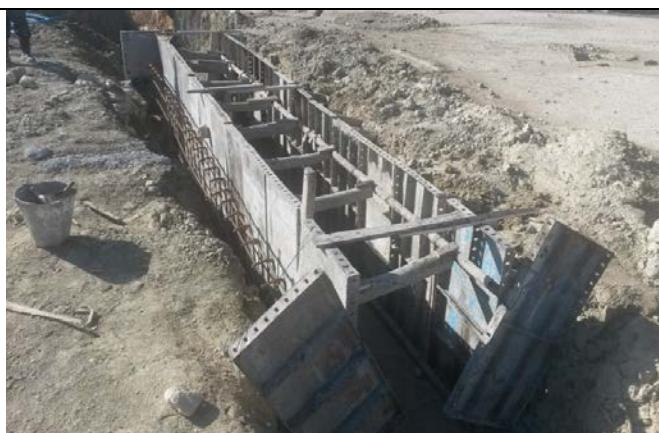
نمایی از قالب بندی دیواره کanal ها جهت بتن ریزی
