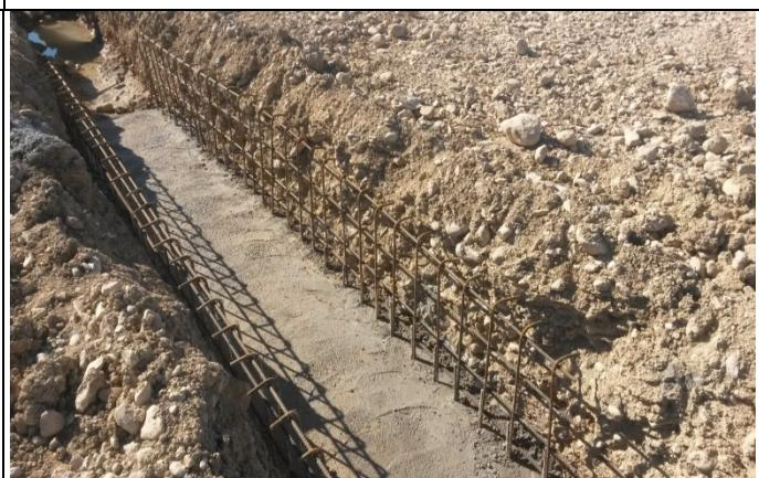
نمایی از میلگرد بافی دیواره کanal ها
