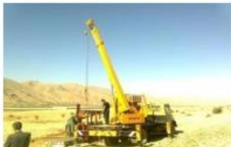
ماشین آلات مخصوصی عملیات ژئوتکنیک
