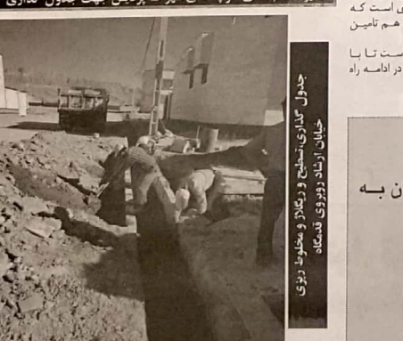
جدول گذاری، تمساح و ریختن و مخلوط ریزی خیابان اریاد درونی قسمت اول
